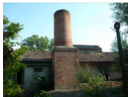
cartiera - ciminiera impianto caldaia
