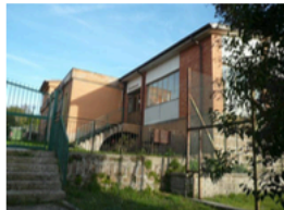
Particolare rampa di accesso
