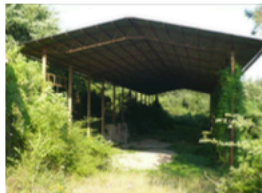
capannone/deposito con copertura in eucalipti
