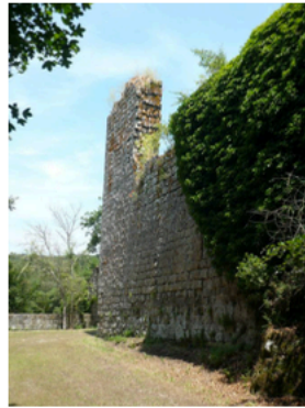
la cinta muraria
