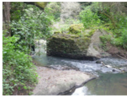
opere di sbarramento
