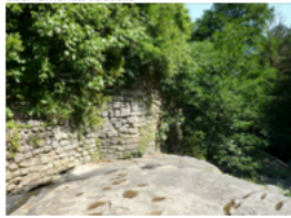
la gora di alimentazione
