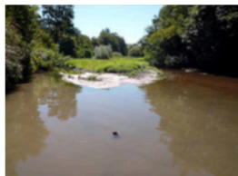
area dell'invaso in prossimità dello sbarramento
